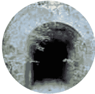
IL VECCHIO TUNNEL Attraversamento della galleria Caprareccia: bisogna avere torce e un giubbotto
